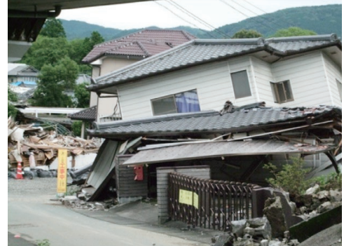
【熊本地震被害状況】
