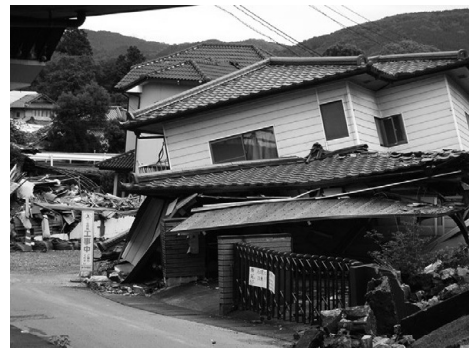
【熊本地震被害状況】
